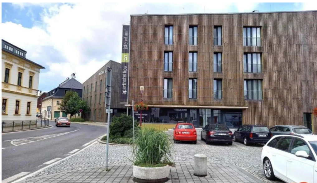
Aparthotel lipa exteriér
