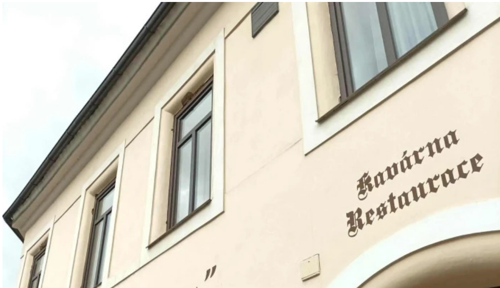
Restaurace u ceskeho lva restaurace
