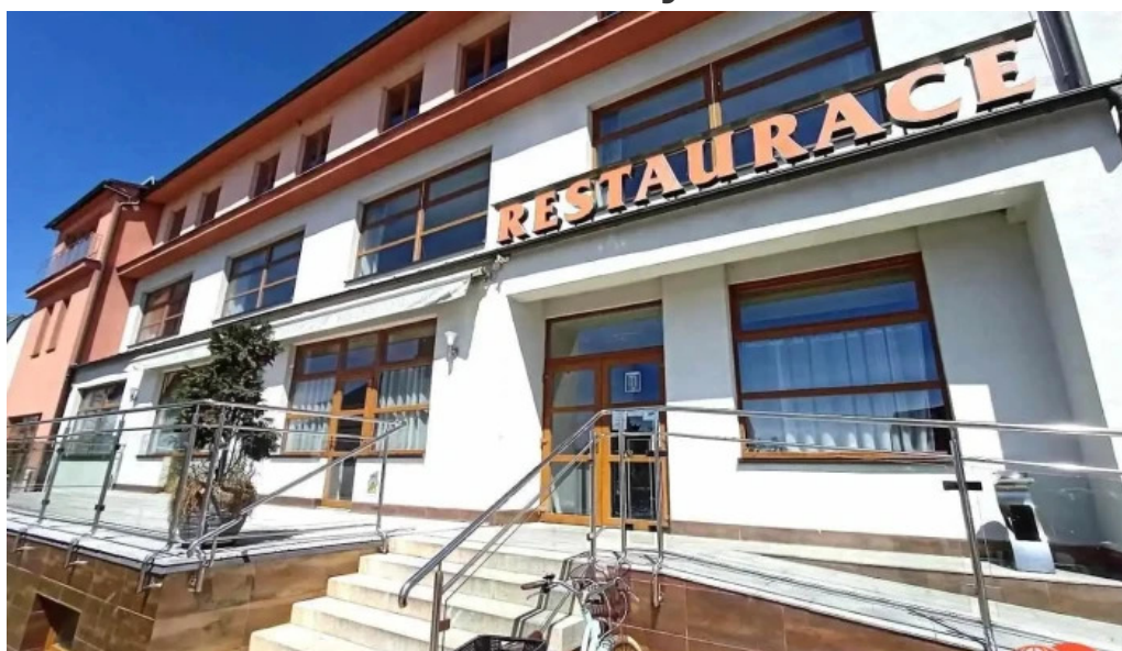
Restaurace křižanov benešovo nám 449
