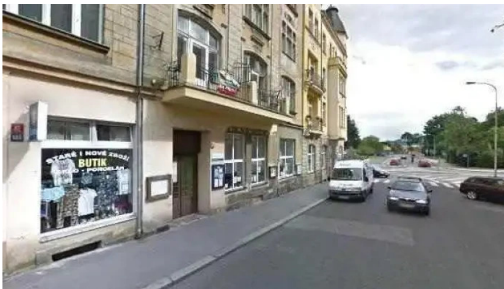
Pivnice na kanale street view a 360deg
