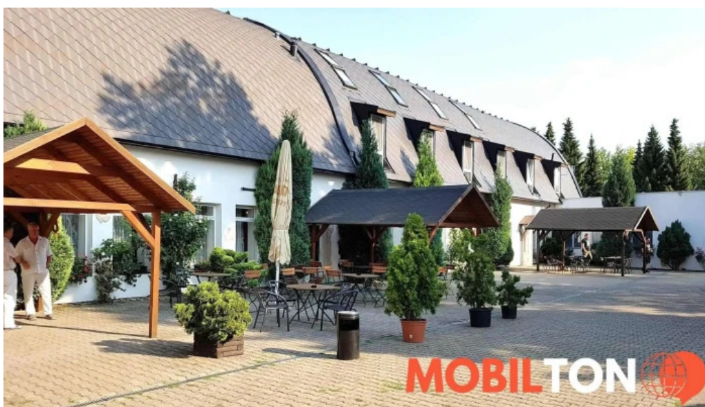
Hotel koliba exterieur
